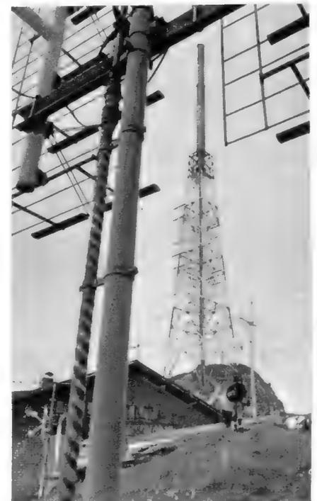
Die 94 m hohe kombinierte Sendeantenne auf dem Grünten. Am Gittermast die Kanal-2-Fern- sehantenne, im zylindrischen Aufsatz die An- tenne des SWF und zwei Sendeantennen für das Zweite und Dritte Programm. Im Vordergrund eine Ballempfangsantenne, links unten das Stationsgebäude im Alpenstil
