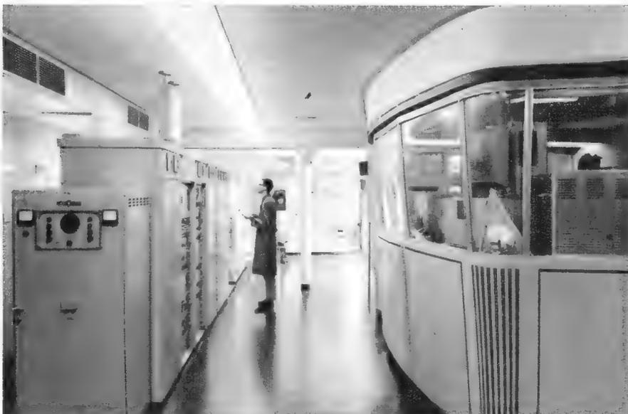
Das Innere der Station läßt nichts von der Bergwelt außen ahnen. In diesem Raum steht links der Kanal-2-Fernsehsender und rechts der Kontrollraum. Er wird demnächst durch einen neuen größeren ersetzt
