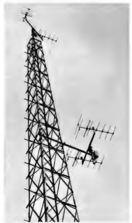
Bild 2. Gitterturm mit Yagi-Antennen
